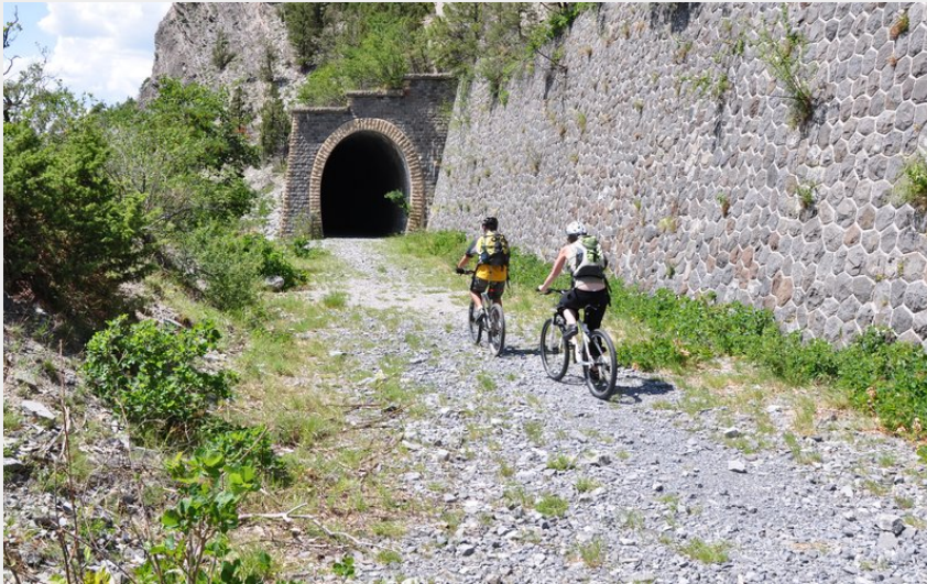
Tunnel du Lauzet (VTOPO)
